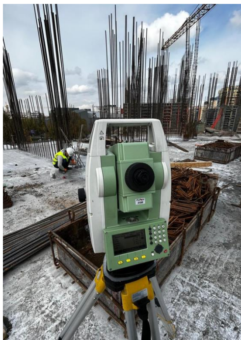
Рисунок 8 – Разбивка осей на строительной площадке
