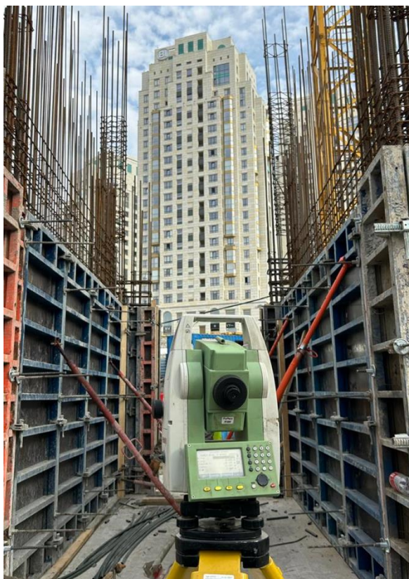
Рисунок 11 – Съемка опалубки перед заливкой стен, колонн
