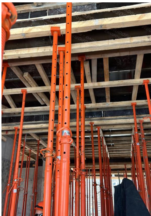
Рисунок 10 – Съемка плиты перекрытия
