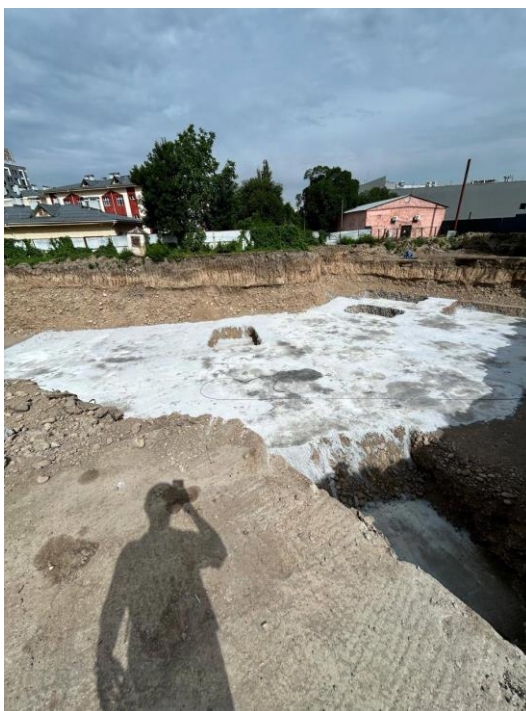
Рисунок 5 – Залитый подбетонный слой
